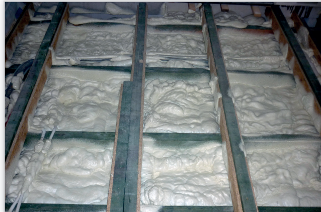
SkutecznaZOLACJA stropu. Poza znakomitymi właściwościami termicznymi SkutecznaZOLACJA ICYNENE wyróżnia się bardzo dobrą dźwiękochłonnością. Pianka może być stosowana jako dodatkowa warstwa dźwiękoizolacyjna, poprawiająca izolacyjność akustyczną budynku, w tym także stropów i podłóg. Może być nanoszona na strop międzykondygnacyjny zarówno z dołu jak i z góry.
