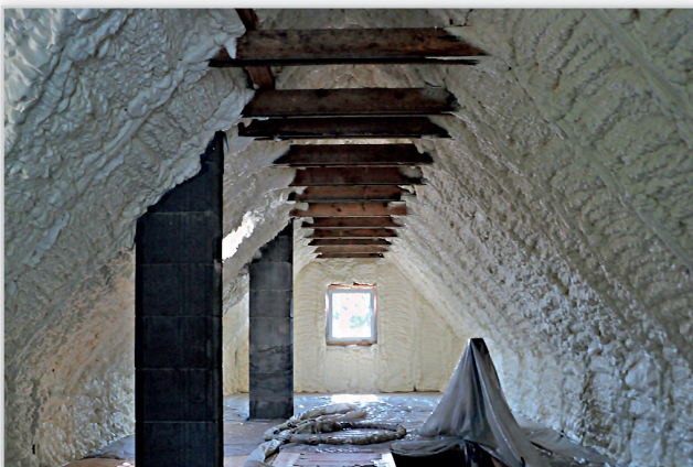
SkutecznaZOLACJA domów drewnianych. Ocieplony kompletnie dom drewniany SkutecznaZOLACJA ICYNENE jest odzwierciedleniem zdrowego, zharmonizowanego budynku. Pianka kanadyjskiego producenta została stworzona do wykonywania izolacji w bezpośrednim natrysku na podłoże drewniane. Dzięki ciągłości izolacji eliminuje mostki termiczne odpowiedzialne za straty ciepła oraz wykraplanie się pary wodnej.
