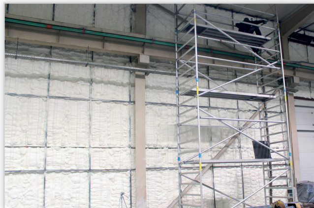
SkutecznaZOLACJA obiektów przemysłowych. Dzięki swej niewielkiej wadze 8,3 kg/m 3 pianka H 2 Foam jest idealnym rozwiązaniem na izolację lekkich blaszanych konstrukcji. Już przy 15 cm grubości SkutecznaZOLACJA redukuje przepływ ciepła w 96%. Doświadczony Autoryzowany Wykonawca jest w stanie wykonać nawet 400 m 2 izolacji w ciągu 1 dnia, skracając czas prac budowlanych jak również czas przestoju produkcji.
