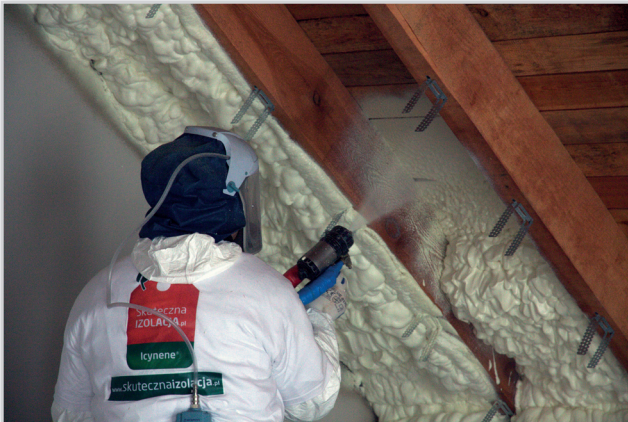
SkutecznaZOLACJA poddasza. Pianka H 2 Foam jest doskonałym materiałem na skuteczną izolację poddasza. Może być nanoszona bezpośrednio na płytę OSB, deski czy nawet folię paroprzepuszczalną. Jest lekka i elastyczna, dzięki czemu nie obciąża dachu i pracuje razem z drewnianą konstrukcją. Jest nieprzewodnym i w pełni paroprzepuszczalnym materiałem.
