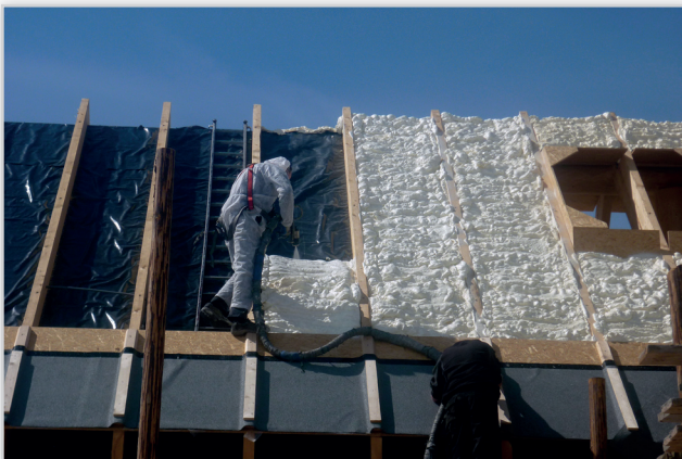
SkutecznaZOLACJA dachu od zewnątrz. Pianka kanadyjskiego producenta ICYNENE to doskonały sposób na szybką i komfortową wymianę starej, nieskutecznej izolacji termicznej od strony zewnętrznej bez konieczności ingerencji w część mieszkalną obiektu. To również doskonały materiał na termomodernizację budynków, w których nie zastosowano wcześniej izolacji.
