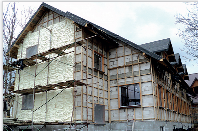
SkutecznaZOLACJA ścian zewnętrznych. Pianka natryskowa H 2 Foam może być również stosowana jako izolacja zewnętrzna ścian. W tym przypadku musi zostać zastąpiona niezależnym wykończeniem elewacji budynku, np. sidingiem (oblicówką). Przed zamontowaniem warstwy paneli, piankę należy przykryć folią paroprzepuszczalną. Tak ocieplona ściana zewnętrzna pozostaje przegrodą paroprzepuszczalną, potocznie mówiąc „oddychającą”.
